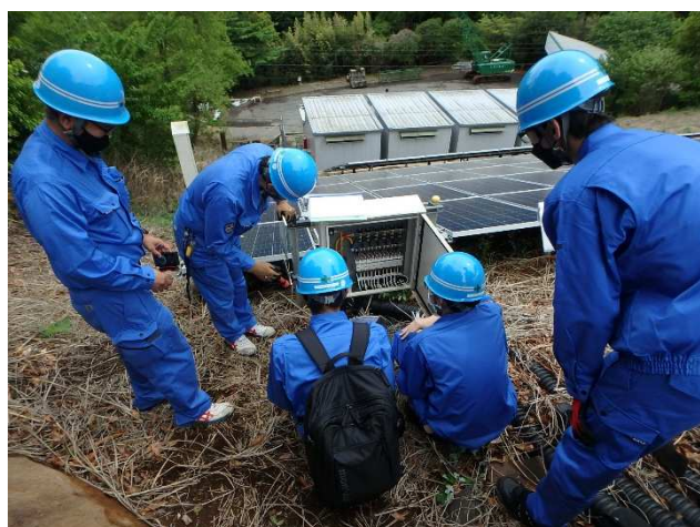
↑ 太陽光発電設備の説明を受けている様子
